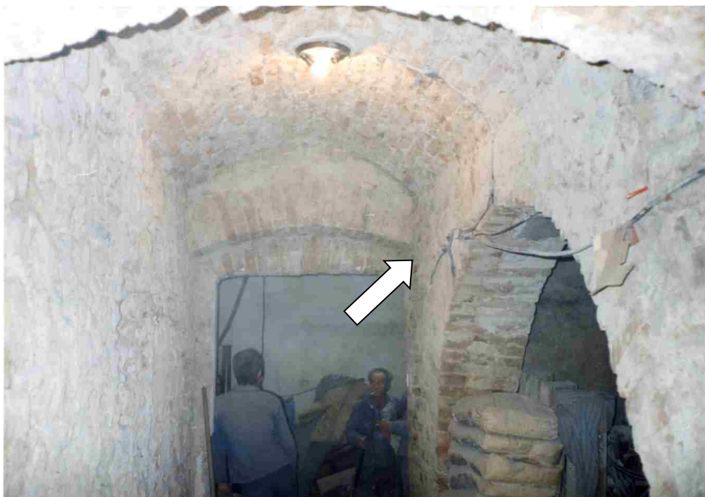
7 prostor v zadním traktu přízemí domu při opravě v roce 1991 - struktura odhalených cihelných kleneb z roku 1727
